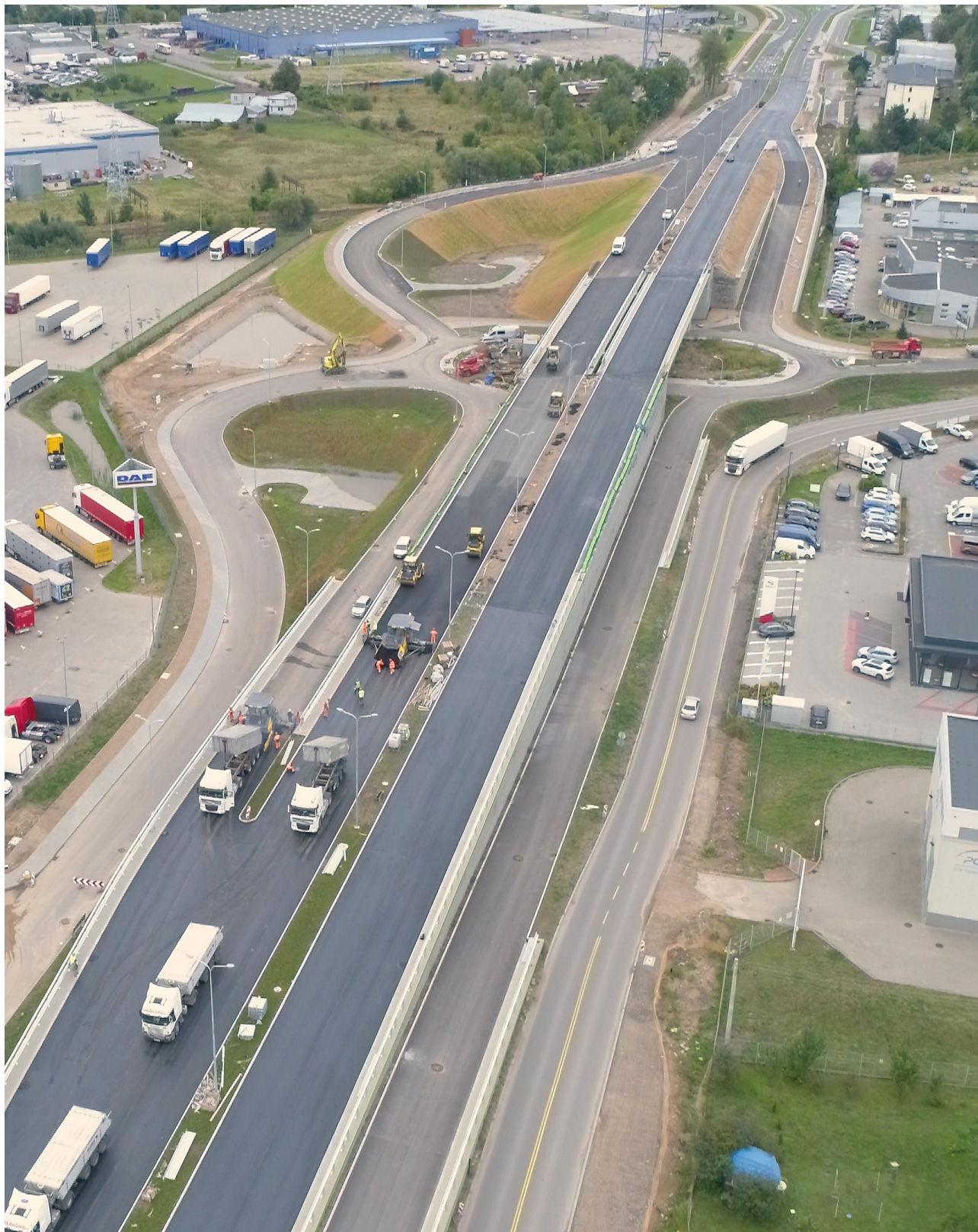
Budowa węzła drogowego w Porosław, Polska
